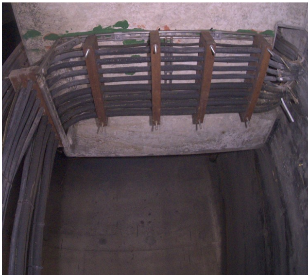
Kabels met bevestigingsbeugels in de bascule kelder Verbinding staalconstructie met klinknagels
